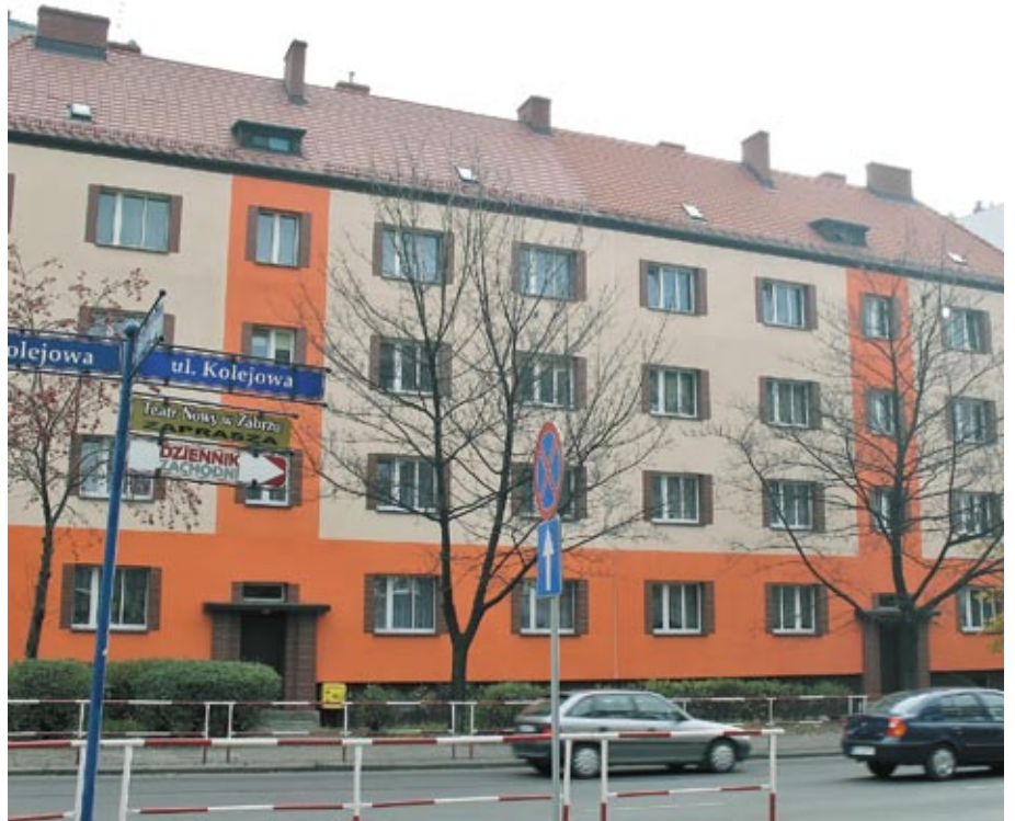
Budynek wspólnoty przy ul. Kolejowej w Bytomiu.
